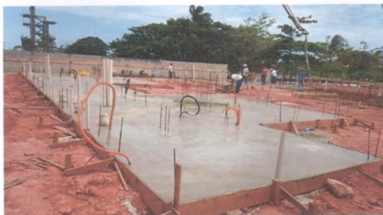
Figura 20 - Fundação em radier após a concretagem
