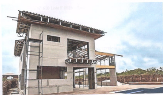
Figura 19 - Casa em steel frame
