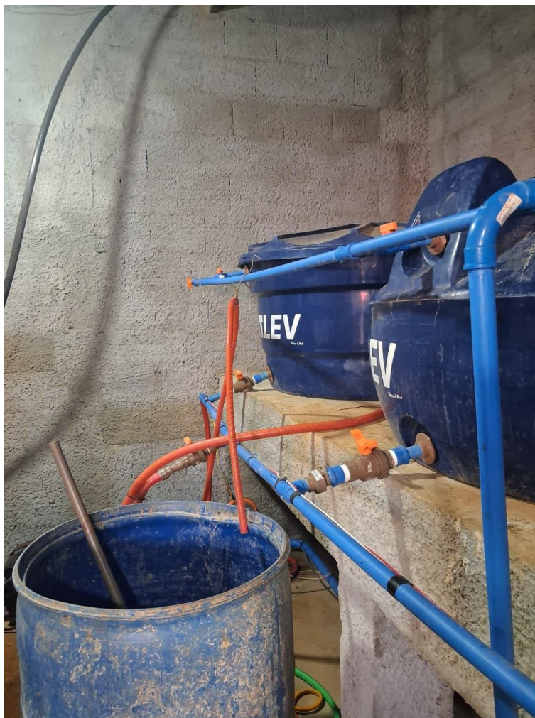
Figura 1 – Caixas d'água para diluição e dosagem de produtos para irrigação.
