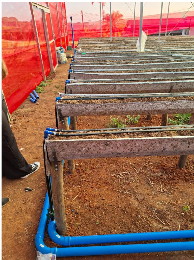
Figura 2 – Tubulações e válvulas para controle do gotejamento nas mudas.
