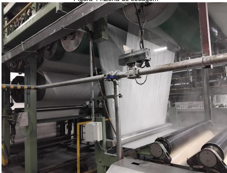
Figura 14: Zona de secagem
