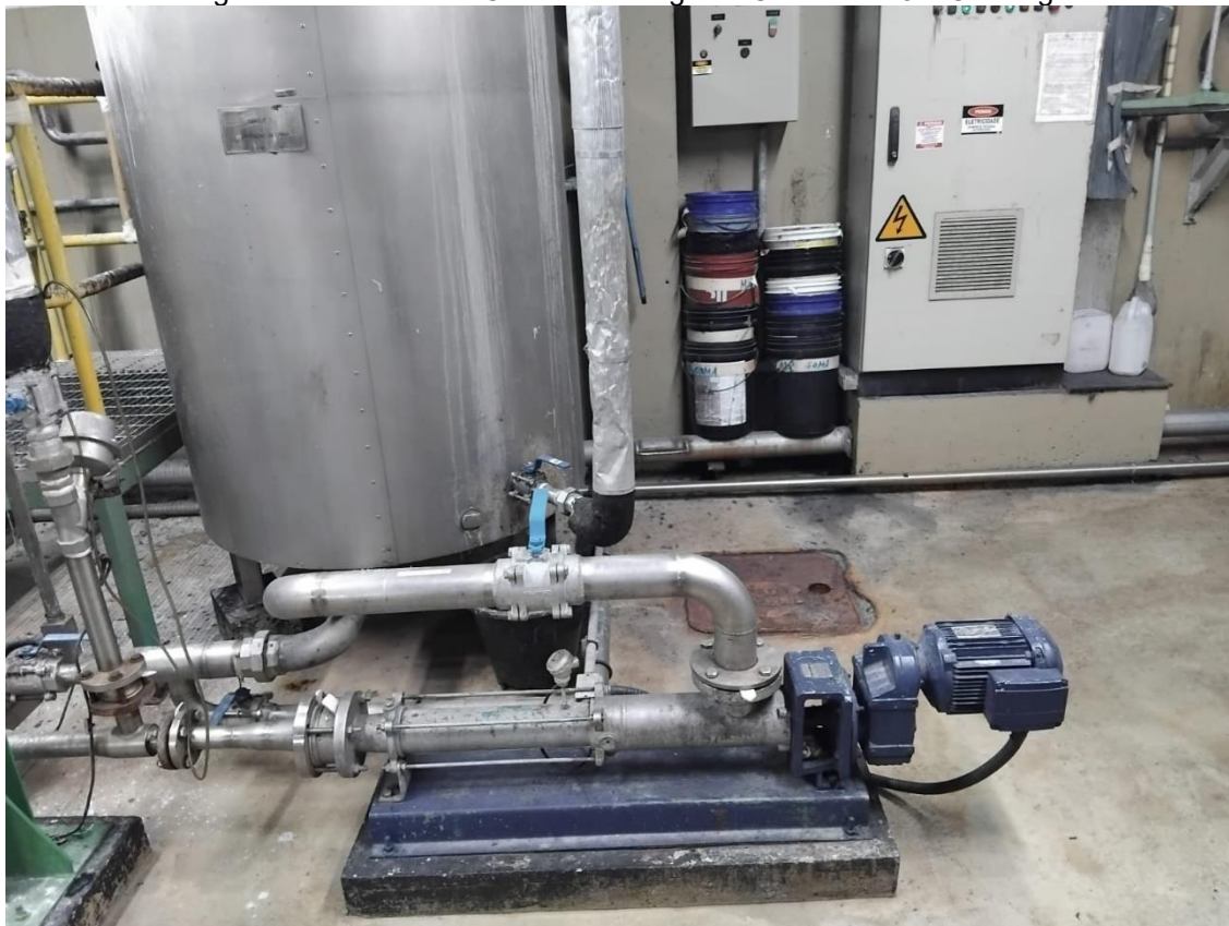
Figura 17: Sistema de Cozimento de goma Contínuo – Jet Cooking
