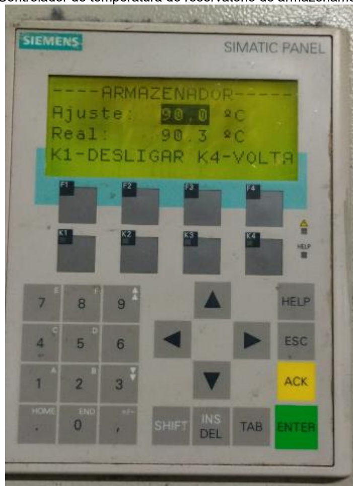
Figura 20: Controlador de temperatura do reservatório de armazenamento de goma
