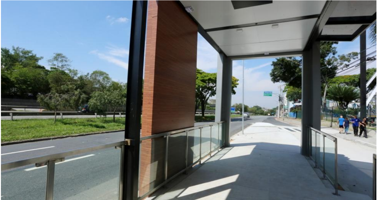
Figura 22 - Interior do abrigo
