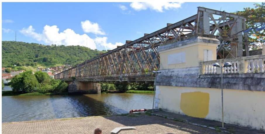
Figura 7 - Vista geral da ponte.
