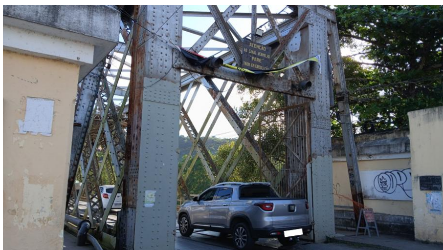
Figura 8 - Vista da entrada da ponte (Cachoeira – São Félix).
