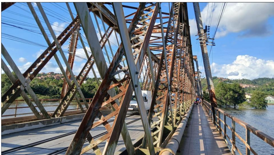
Figura 4 - Vista da via de pedestres.
