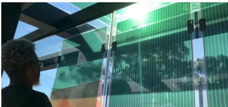
Figura 7: Aplicação da película OPV ao vidro
