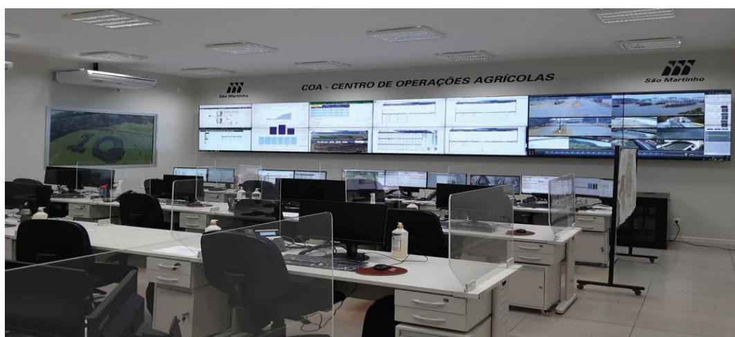
Figura 3 - COA Usina São Martinho
