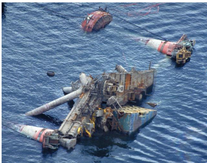
Figura 8 – Plataforma Alexander Kirk virada após rompimento de uma coluna
