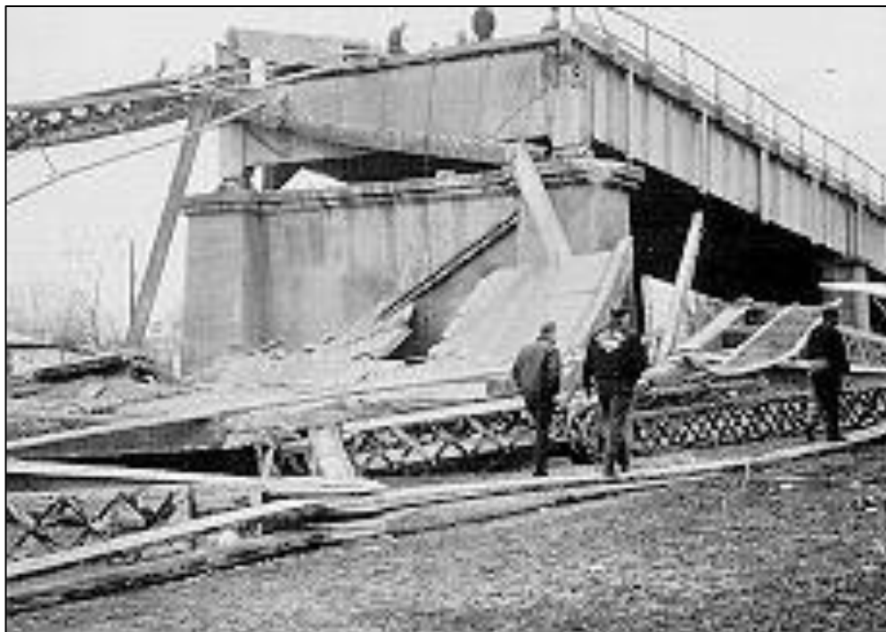
Figura 11 – Ponte Silver Bridge, colapsada após falhas estruturais
