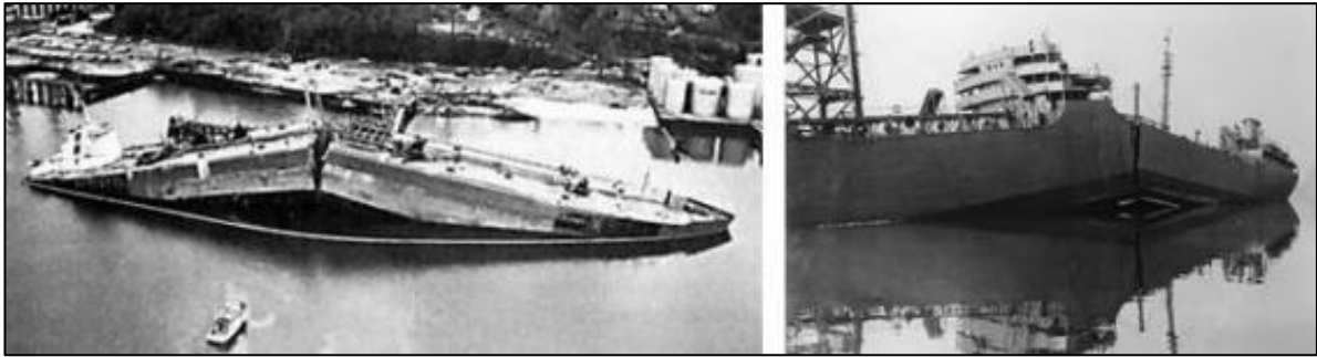
Figura 12 – Fratura ao meio no navio SS Schenectady da série Liberty ocorrida por fratura frágil.
