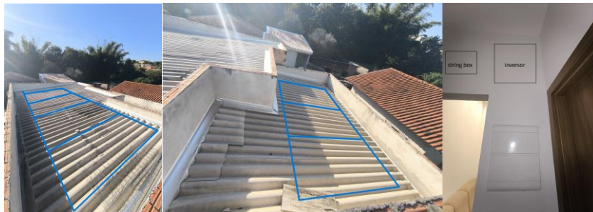
Figura 8 – Imagens Visita Técnica
