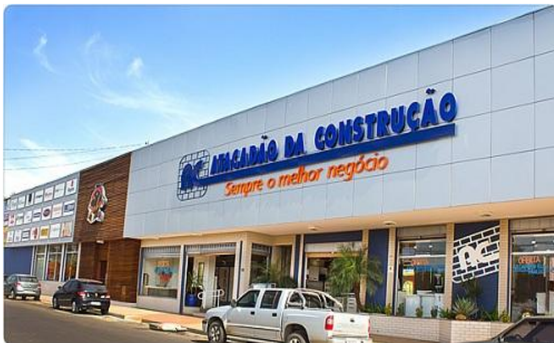
Figura 2: layout externo Atacadão da construção.(Site Atacadão da construção)
