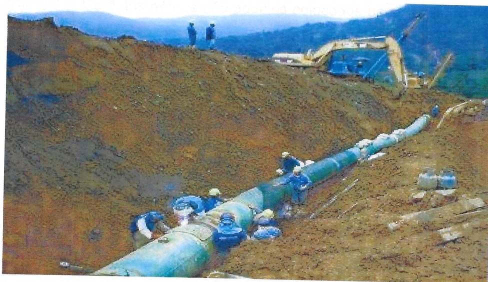
Figura 26: Construção de dutos enterados
