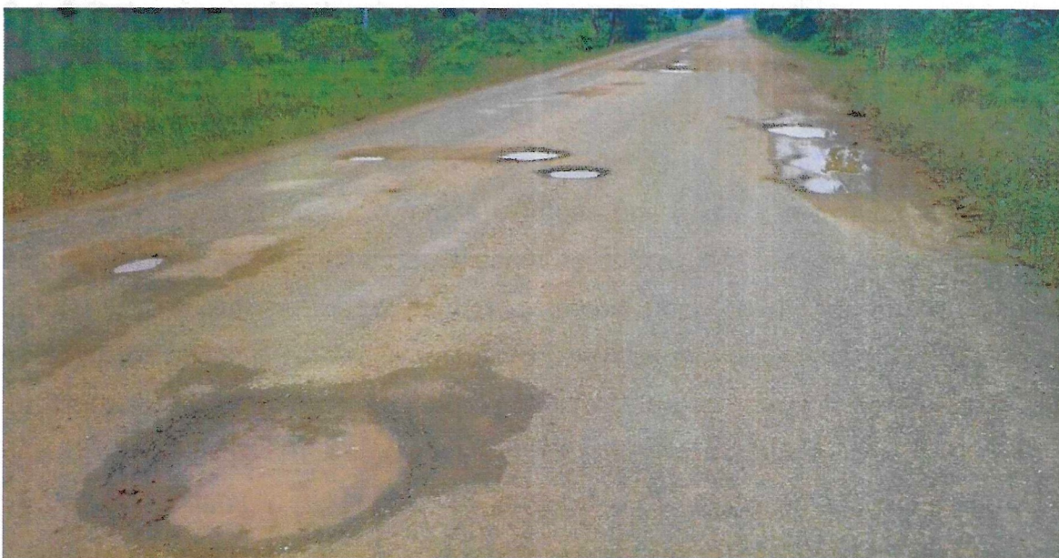
Figura 32: Buracos e asfalto gasto em trecho da BR-210 (Roraima); de uma extensão de 943 km.
