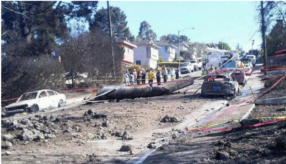
Figura 7 - Restos de uma parte do gasoduto após a explosão.
