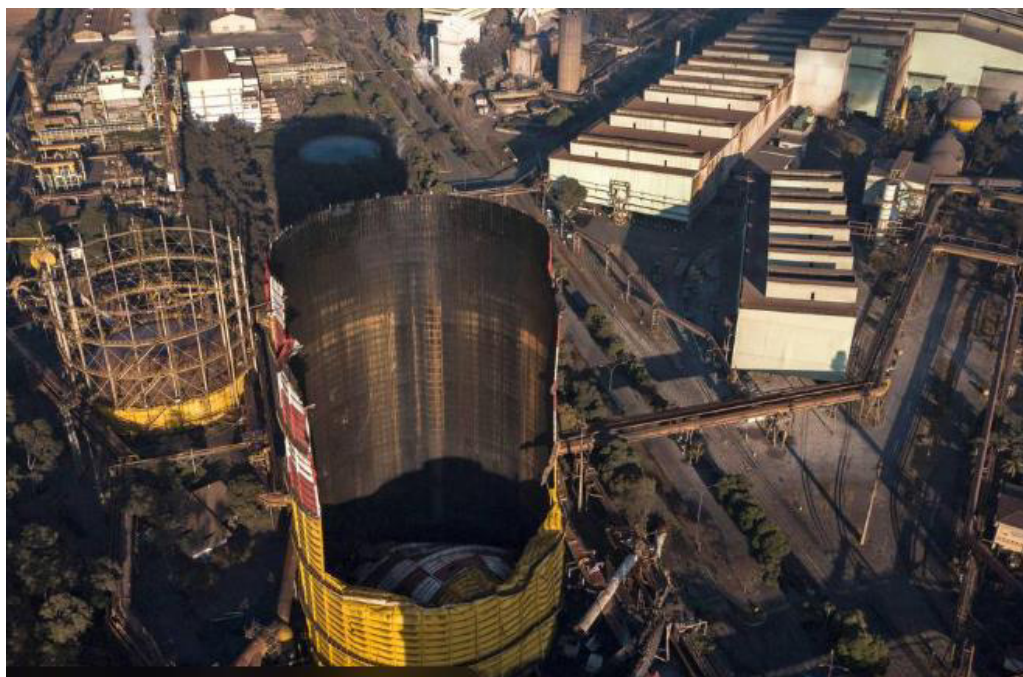
Figura 23 – Vista aérea do gasômetro após a explosão
