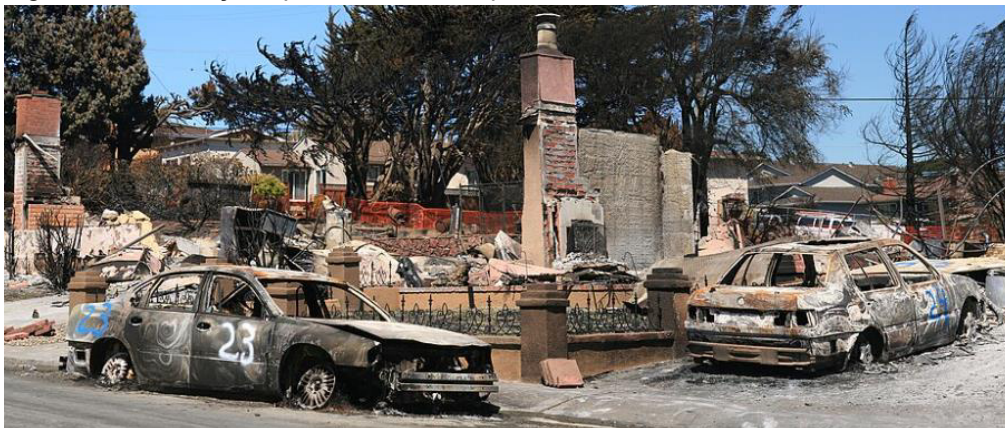
Figura 8 - Destruição após incêndio e explosão em San Bruno
