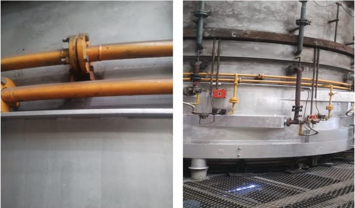
Figura 10 – Tubulações Após modificação (visão 2).
