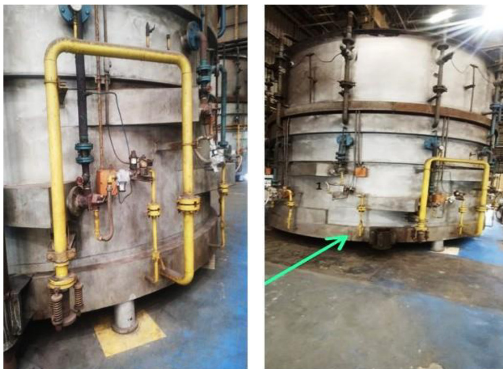
Figura 3 – Entrada antiga de gás no forno.
