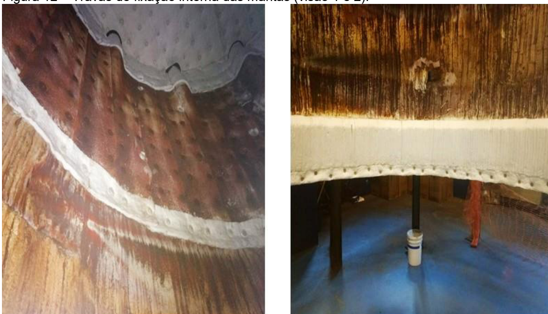
Figura 12 – Travas de fixação interna das mantas (visão 1 e 2).
