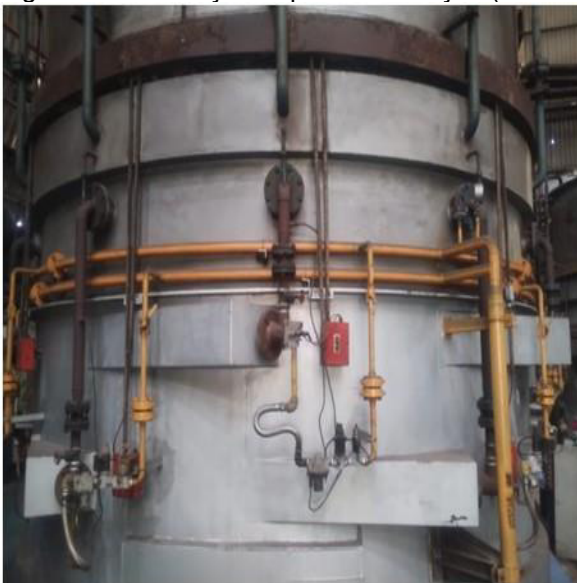
Figura 9 – Tubulações Após modificação (visão 1).
