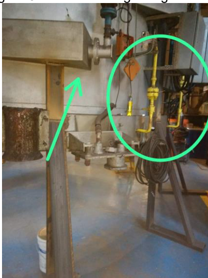
Figura 8 – Entrada antiga de gás no forno.
