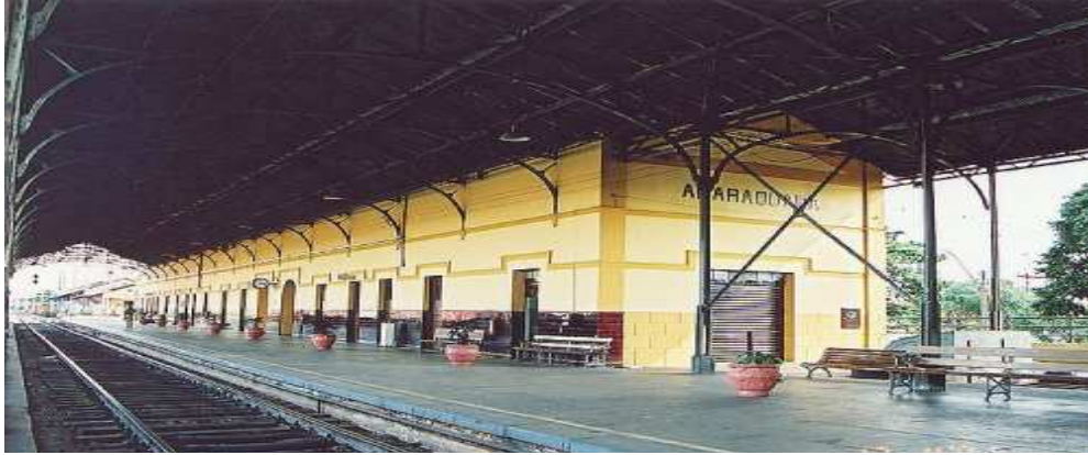
Figura 4. 4. – Estação Ferroviária de Araraquara.
