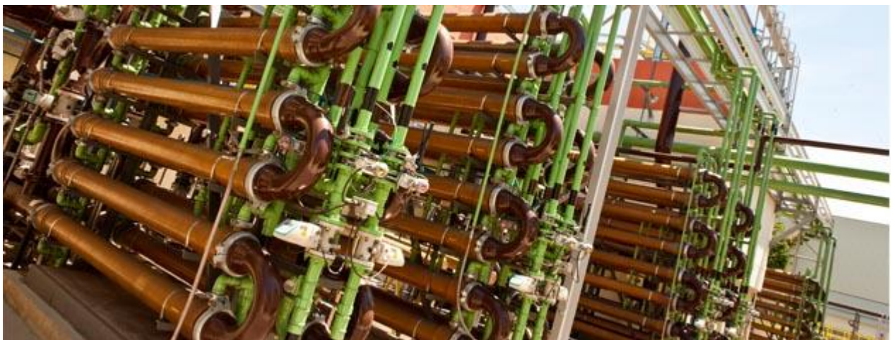
Figura 30 – Sistema de Tratamento Efluente da Água Fonte: Site da Fiat
