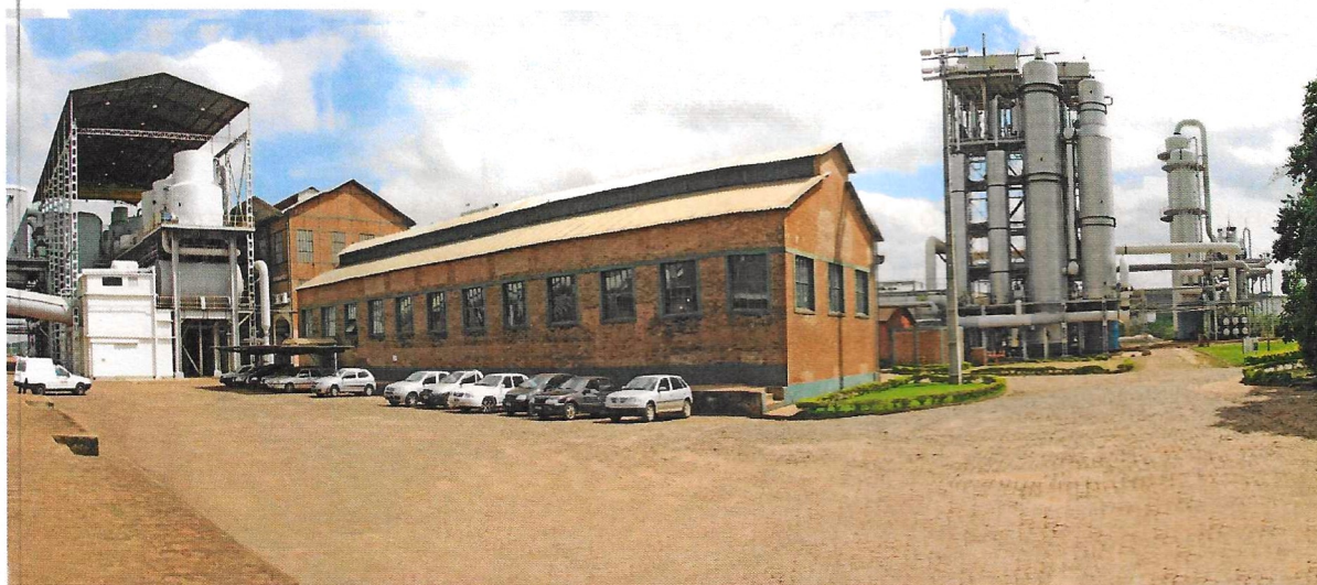
Entrada da Usina Santa Fé
