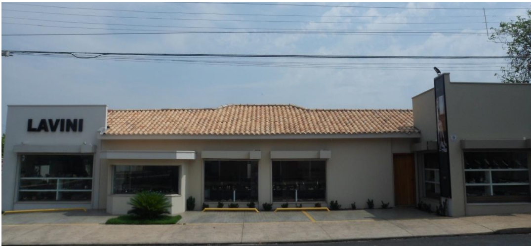
Figura 2: Fachada da Loja.
