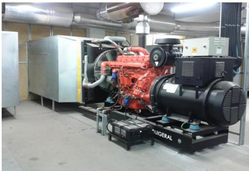
Fig. 1 – Grupo Motor Gerador (GMG) (Foto do Acervo Técnico do Prof. Fernando Garup Dalbo).
