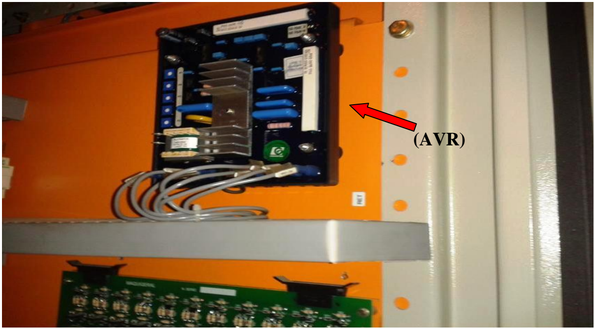
Fig. 43 – Vista Interna do Quadro do Controlador, no Destaque (AVR) (Foto do Acervo Técnico do Prof. Dalbo)
