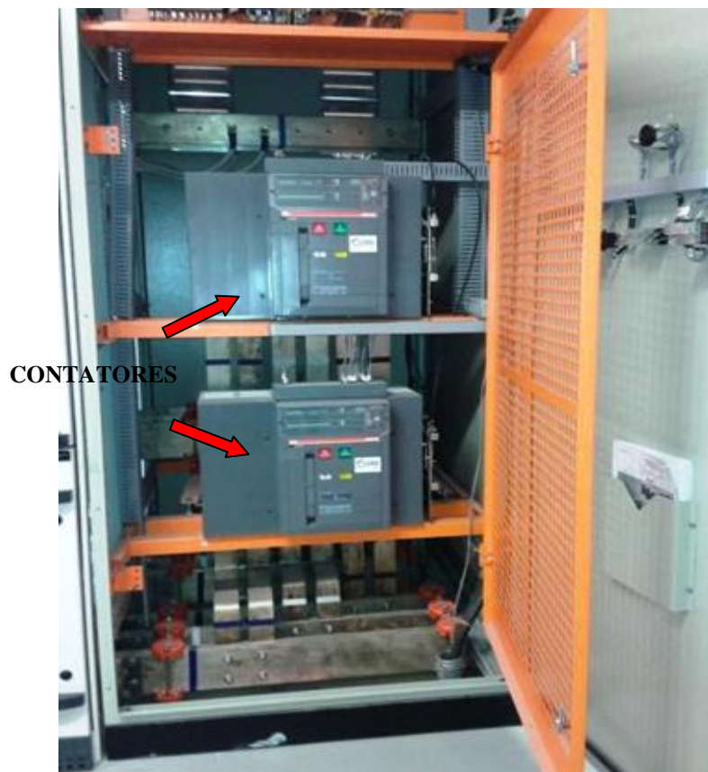
Fig. 38 – Quadro contendo (Contatores) Chaves de Transferência Automática (Foto do Acervo Técnico do Prof. Dalbo).
