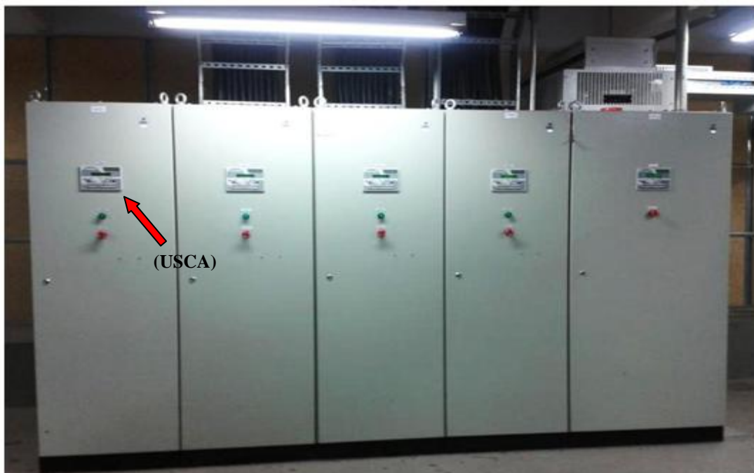
Fig. 40 – Quadros dos Controladores (USCA) (Foto do Acervo Técnico do Prof. Dalbo).
