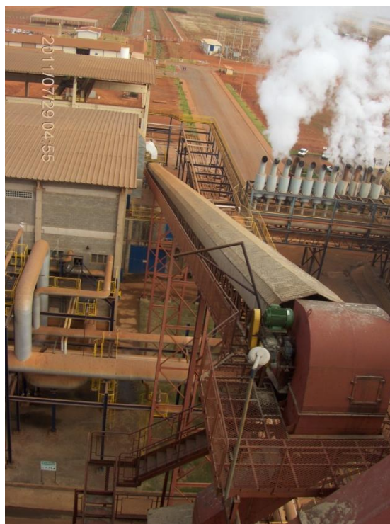
Figura 8 - Transportador de Bagaço na saída da moenda (AMARAL, 2012)
