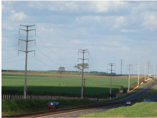
Figura 20 - Distribuição dos postes às margens da rodovia (AMARAL, 2012)
