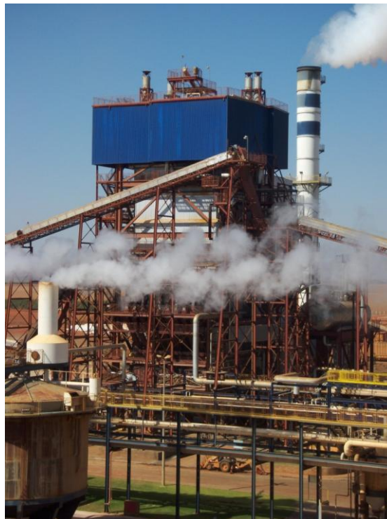
Figura 11 - Vista geral da caldeira (AMARAL, 2012)
