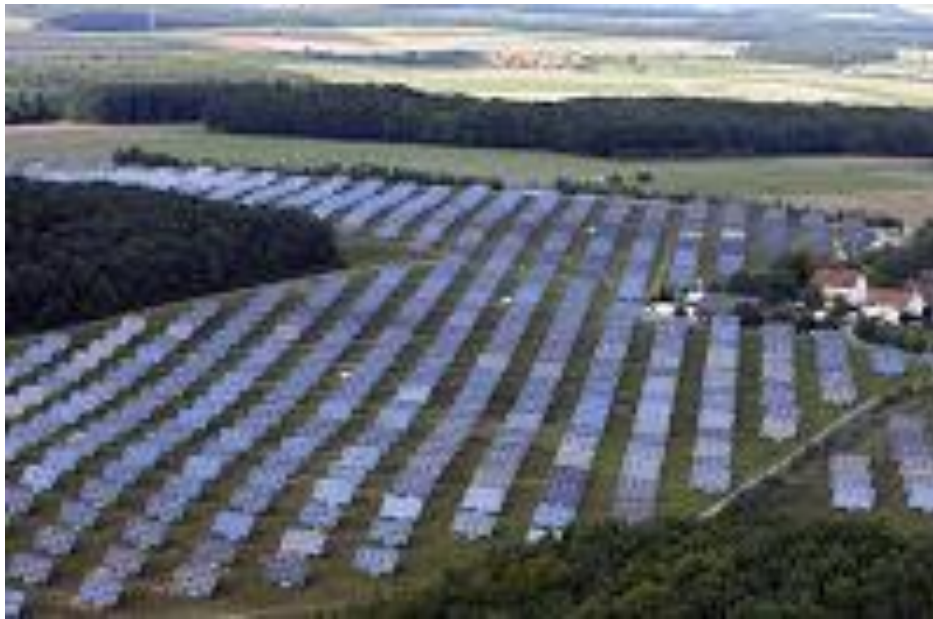
Figura 2 - Painéis de energia solar (TORRES, 2012)
