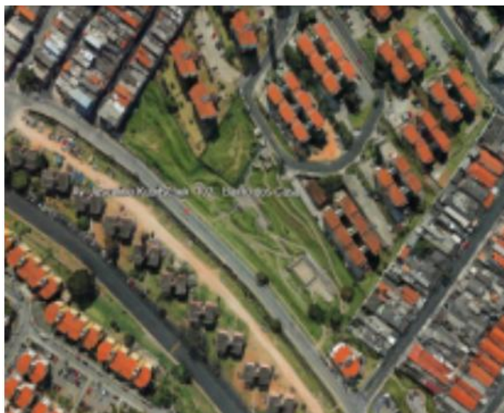
Figura 16 – Imagem Aérea (2) – Avenida Juscelino Kubitschek, 102
