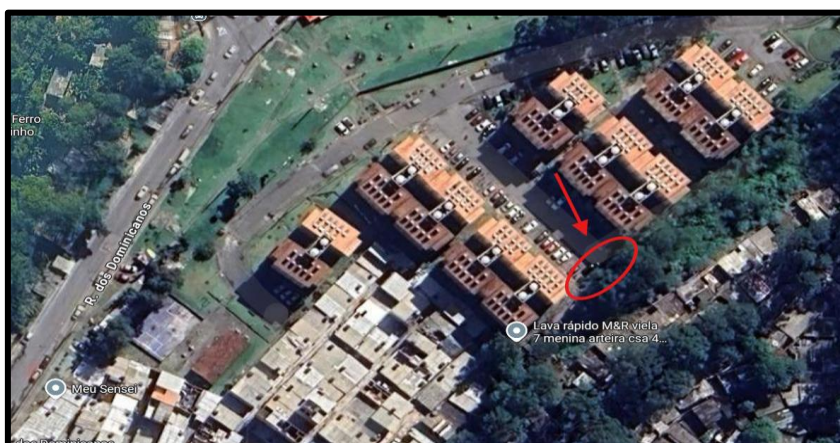
Foto da localização do condomínio CDHU Nova Esperança via satélite Google Maps.
