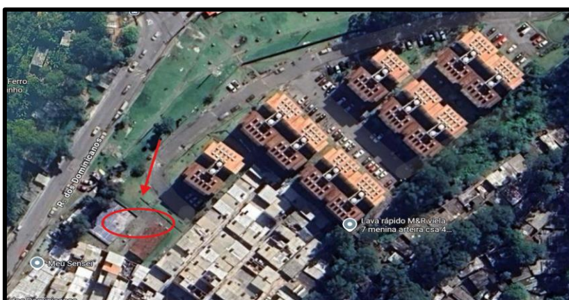
Foto da localização do condomínio CDHU Nova Esperança via satélite Google Maps.
