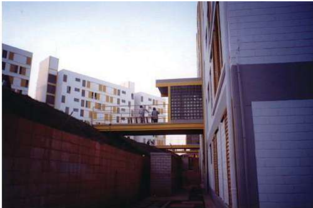
Figura 28 • Conjunto Habitacional Sanko Diadema F, 500 unidades. Último contrato do PPM que permitiu contratação de projeto próprio da Associação elaborado por assessoria técnica. Possui 50 m 2 de área útil.
