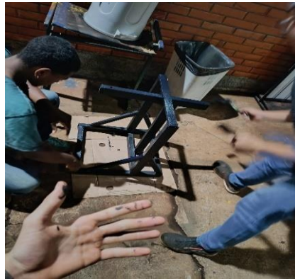
Imagem 11 – Realização da pintura da estrutura depois da solda
