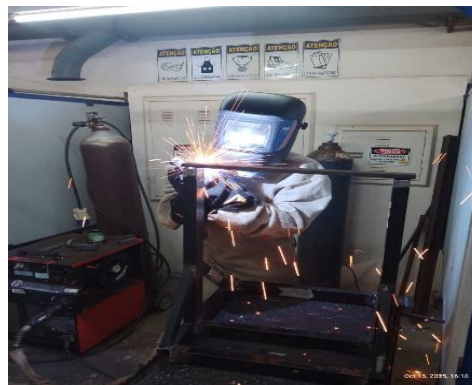
Imagem 6 – Soldagem das vigas para a estrutura 01
