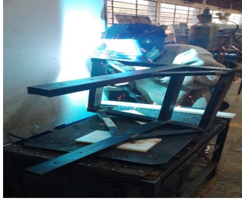
Etec Jacinto Ferreira de Sá - 066 – Ourinhos Imagem 10 – Soldagem das vigas para a estrutura 05
