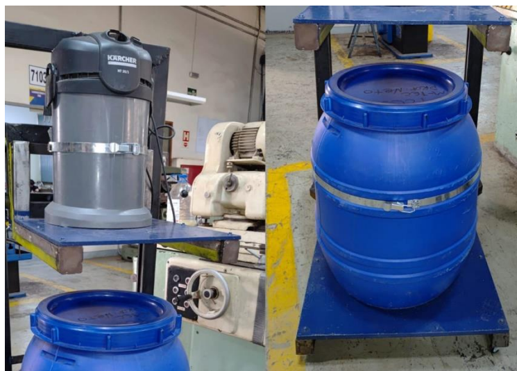
Figura 9 – Passo 10º Soldagem das barras de ferro na estrutura para fixação das cintas
