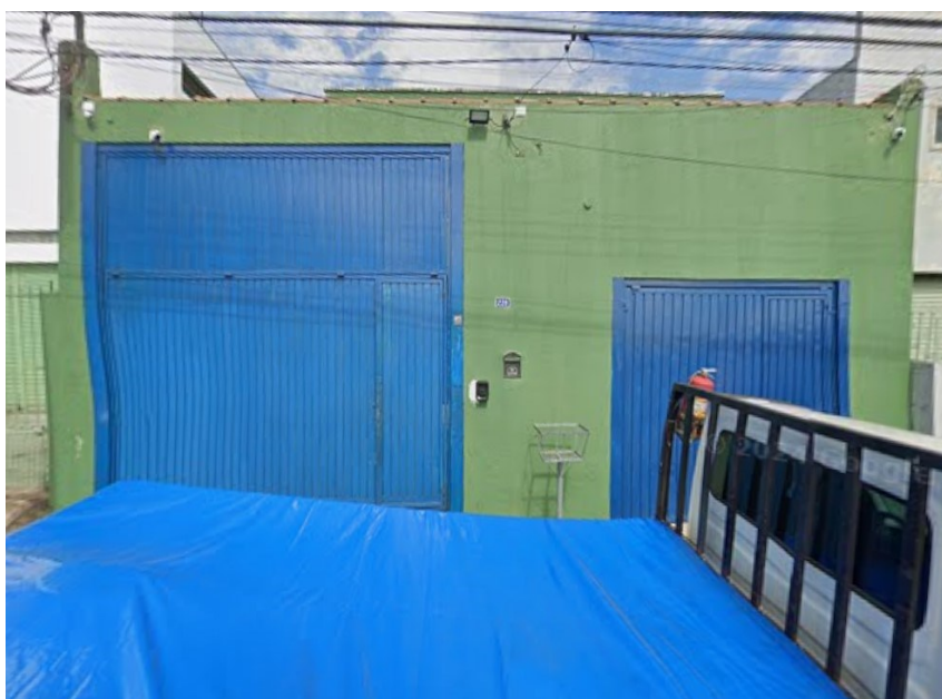
Figura 11 – Fachada RLD Cromeação LTDA
