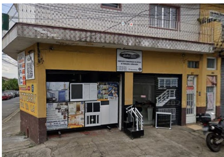
Figura 07: Fachada Lider serralheria e vidraçaria
