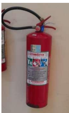
Figura 1 – Extintor água
