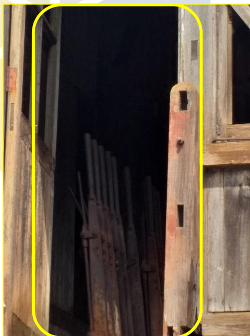
Figura 8 - Detalhes das alavancas ainda existentes na cabine do Recanto
