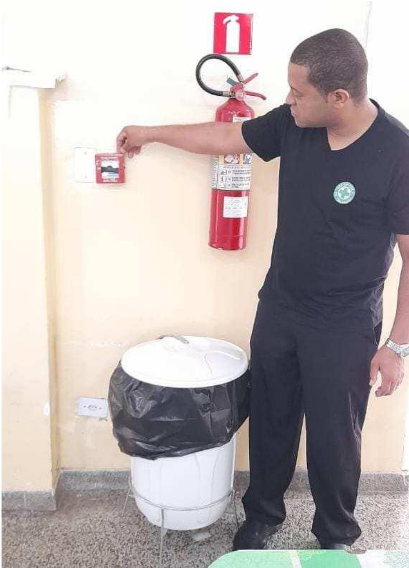
Figura 9- VISTORIA NA BOTOEIRA E EXTINTORES.
