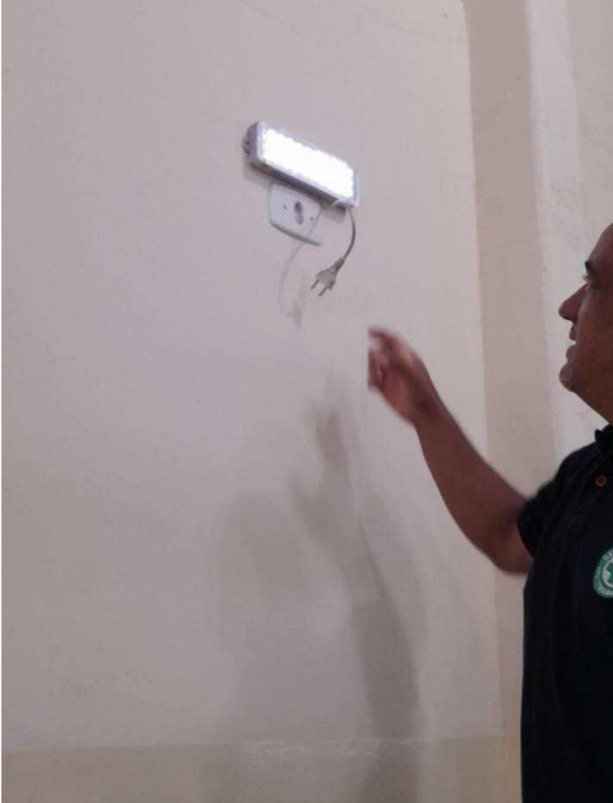
Figura 8- VISTORIA NA LUZ DE EMERGÊNCIA
