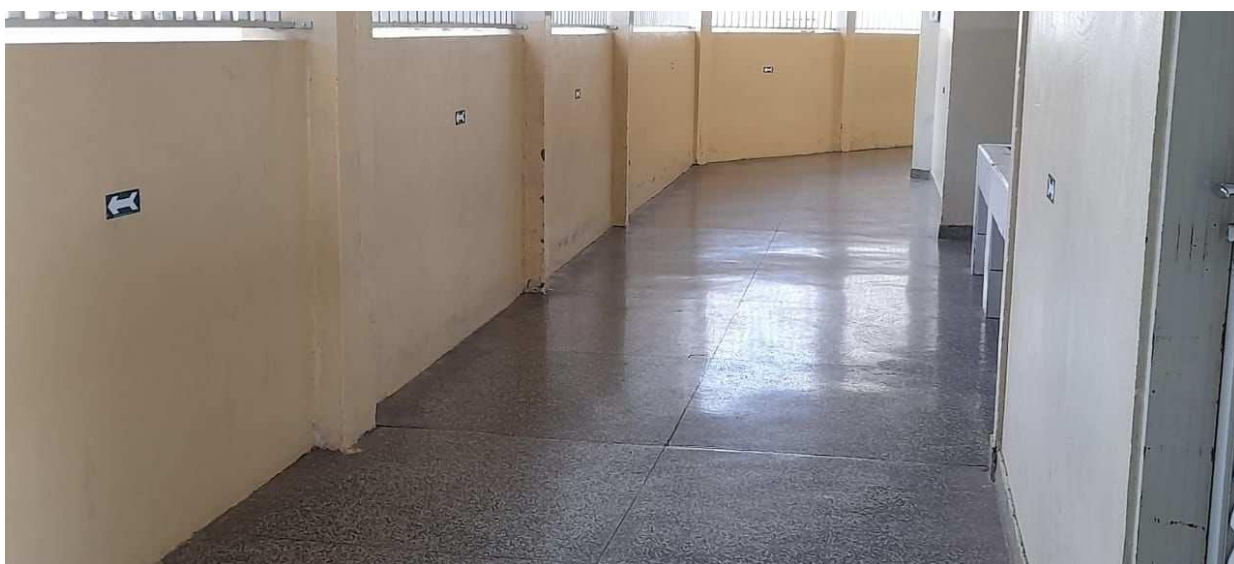
Figura 16- CORREDOR COM SINALIZAÇÃO ROTA DE FUGA 1
