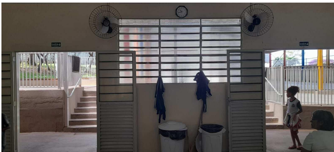
Figura 15- REFEITÓRIO COM SINALIZAÇÃO DE SAÍDA
