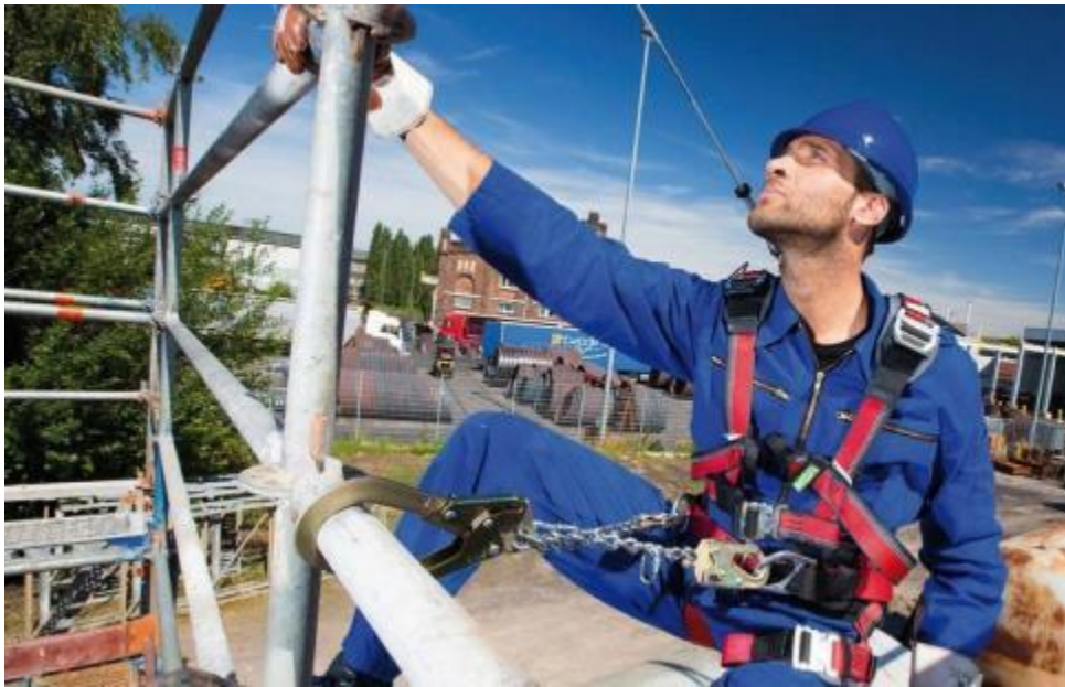
Figura 06 – Trabalhador em cima do andaime com os EPIS necessários
