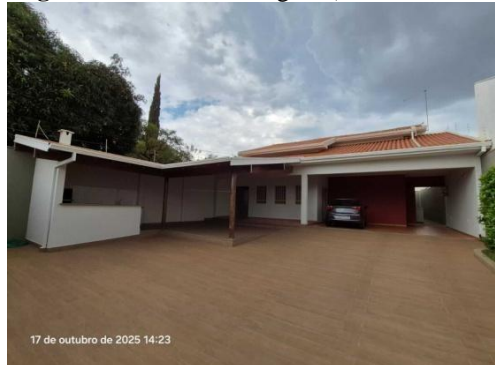
Figura 3 – Entrada/Garagem (imóvel avaliando)
