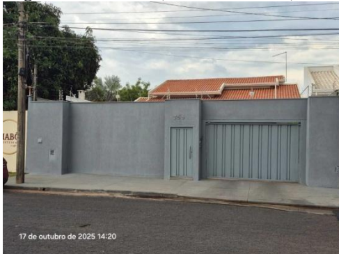
Figura 2 – Fachada (imóvel avaliando)
