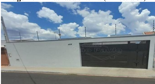
Imagem 94 – Fachada externa (Amostra 07)
