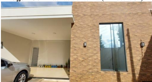
Imagem 30 – Fachada externa (Amostra 02)
