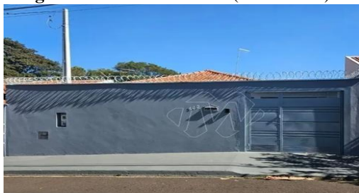
Imagem 73 – Fachada externa (Amostra 05)
