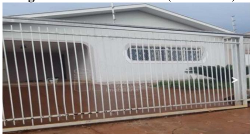
Imagem 16 – Fachada externa (Amostra 01)
