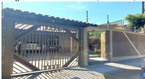
Imagem 58 – Fachada externa (Amostra 04)
