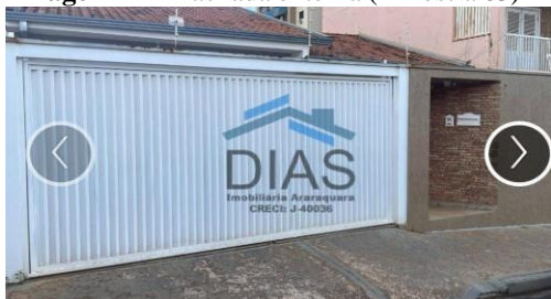
Imagem 44 – Fachada externa (Amostra 03)
