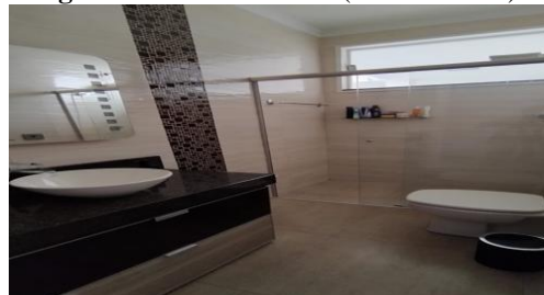
Imagem 5 – Banheiro social (Im Avaliando)
