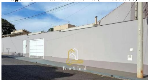
Imagem 81 – Fachada externa (Amostra 06)
