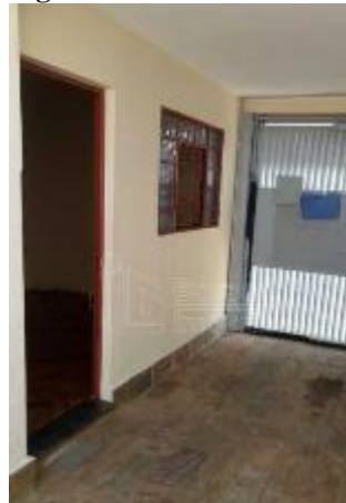
Figura 20 - Acesso sala amostra 1
