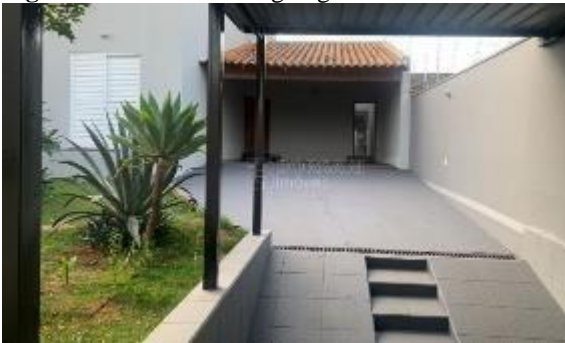
Figura 22 - Vista acesso garagem amostra 2
