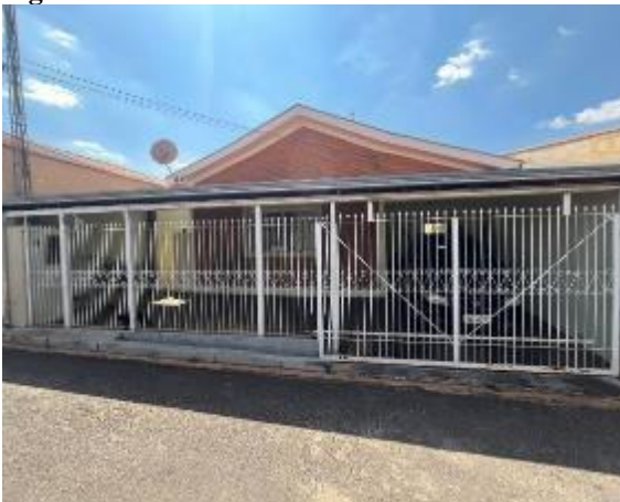
Figura 2 - Fachada imóvel avaliando
