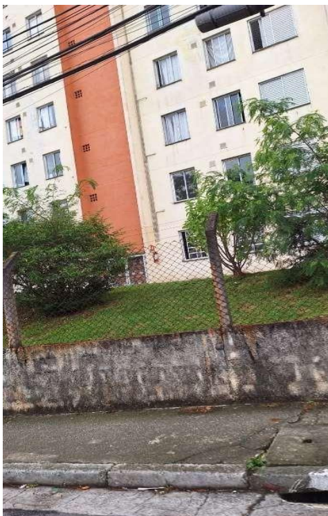
Fig. Cercado de muro com alambrado
