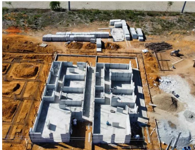
Figura 21: Construção de residências com Blocok
