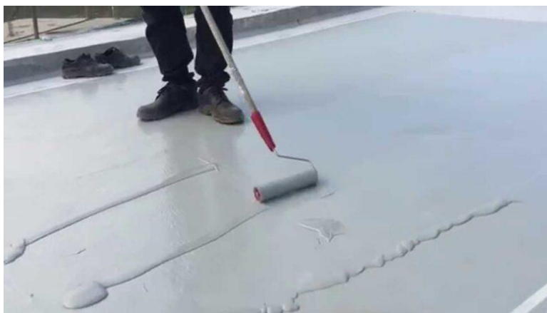
Figura 25: Impermeabilização de laje
