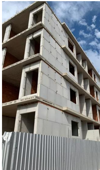
Figura 20: Utilização do Blocok para a construção de edifício residencial
