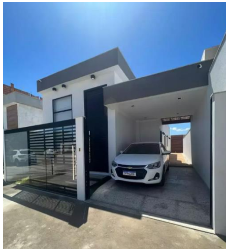
Figura 22: Fachada de casa construída com Blocok
