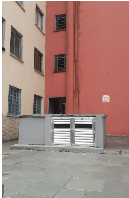
Figura 12: Área entre a entrada e o prédio
