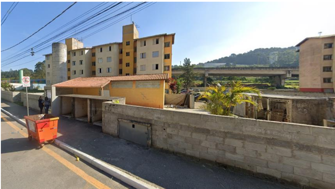
Figura 16: Vista frontal do condomínio
