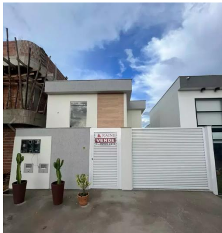
Figura 23: Fachada de casa construída com Blocok
