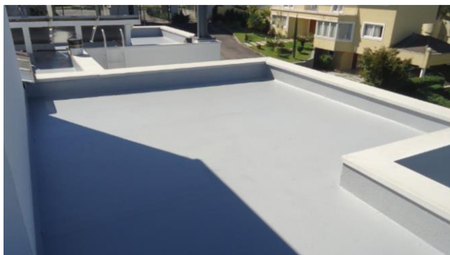
Figura 24: Cobertura em laje
