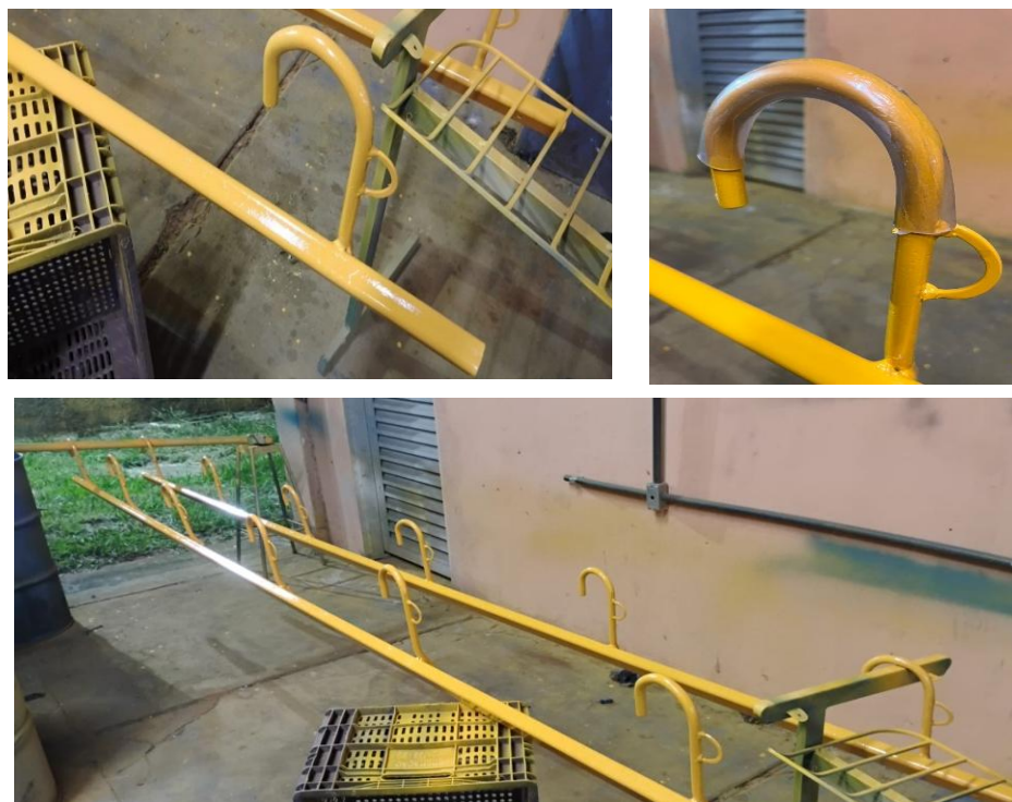
Figura 4 – Acabamento e pintura
