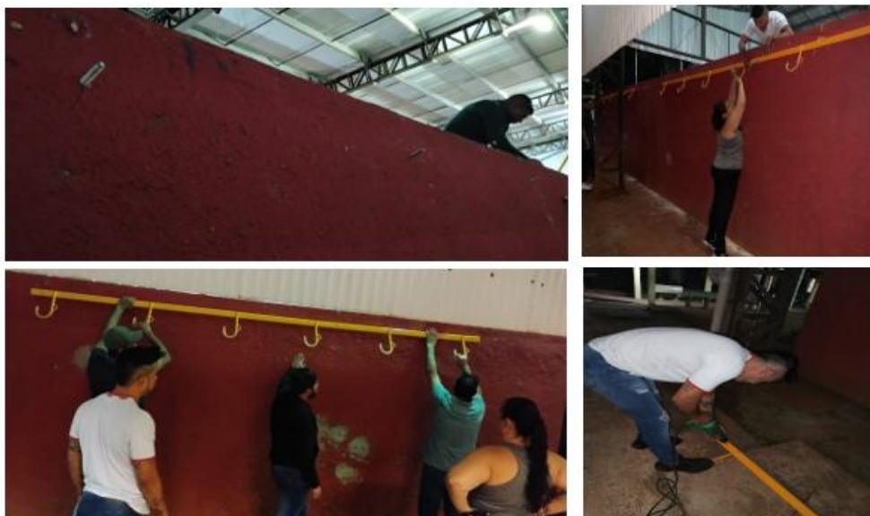
Figura 5 – Fixação na Parede
