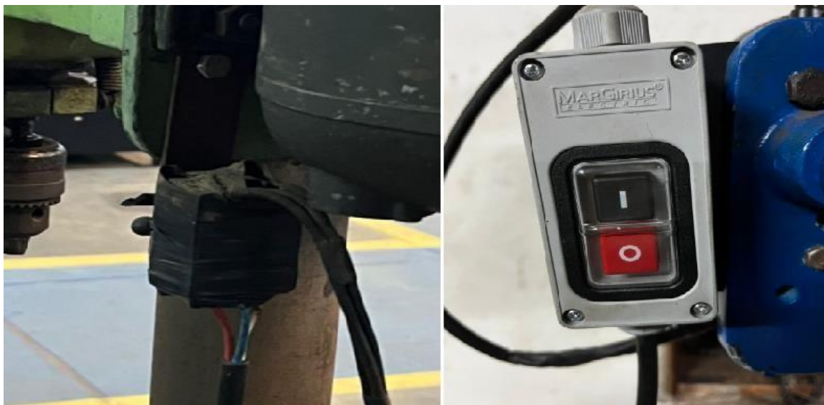
Figura 7: Troca do botão liga e desliga, botão de emergência nr12, mais contadora
