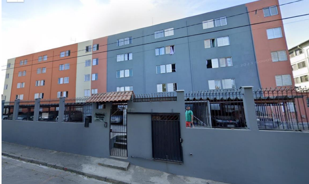
Figura 9: Fachada frontal do conjunto
