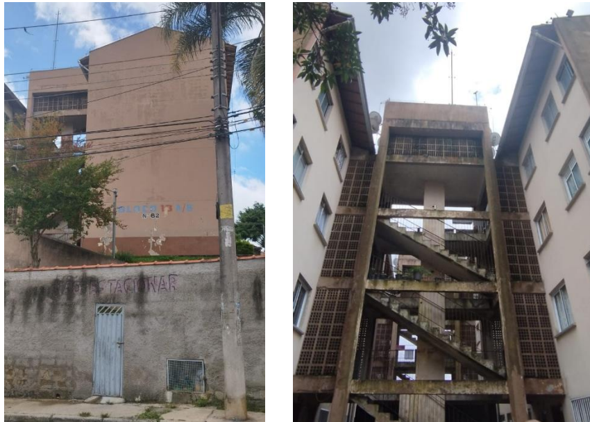
Figura 5 e 6: Apresentação da fachada do conjunto
