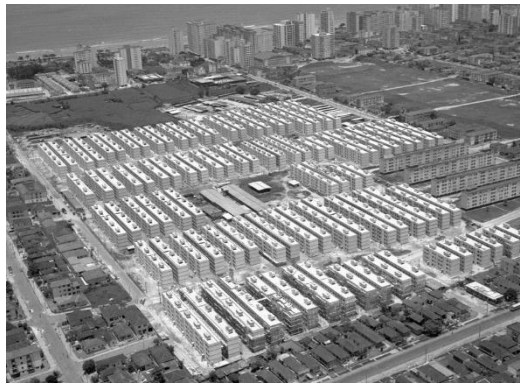
Figura 2: Vista aérea do Conjunto Habitacional Humberto de Alencar Castelo Branco
