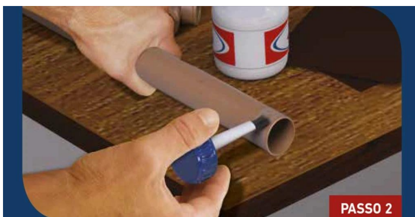
Figura 42 – Exemplo de aplicação de vedação em junta.
