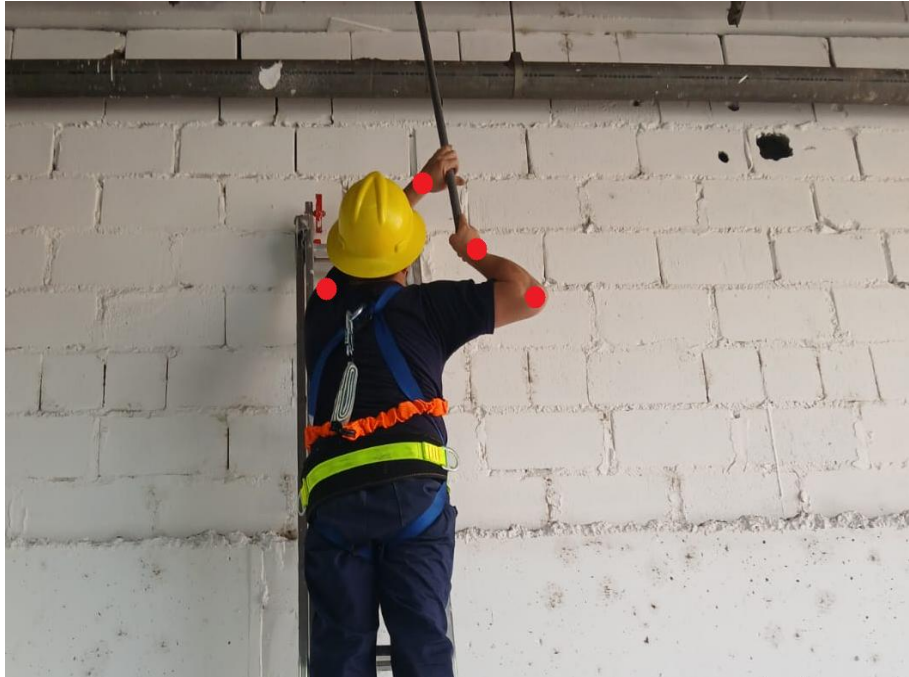
Figura 2: Postura de elevação dos membros superiores na pintura de partes altas da parede.
