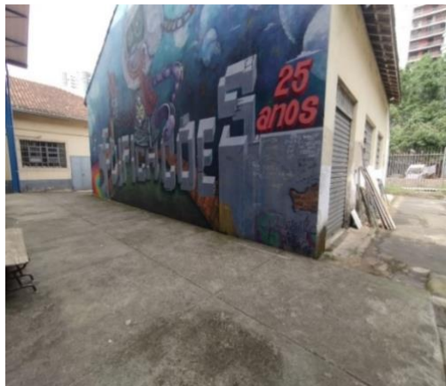
Figura 41. Vista frontal do Bloco D
