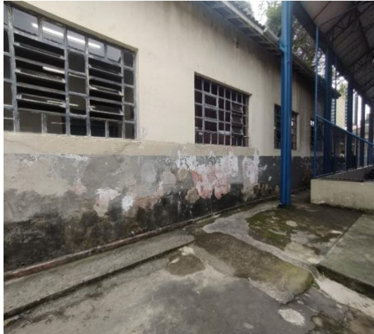
Figura 40. Vista lateral esquerda do Bloco C
