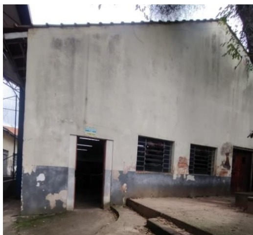
Figura 39. Vista Frontal do Bloco C
