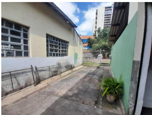
Figura 1. Corredor entre o Bloco C e D
