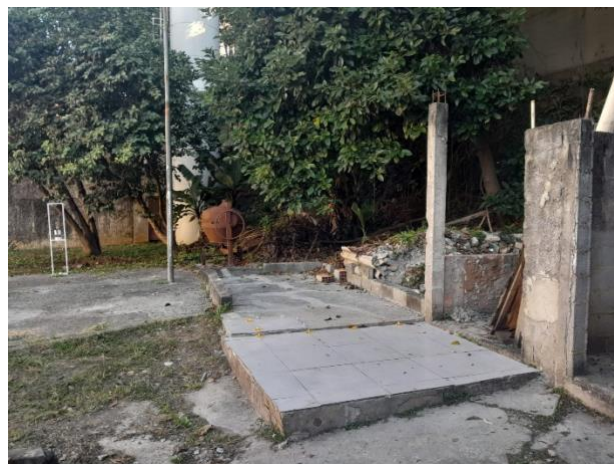
Figura 6. Área externa do Bloco C
