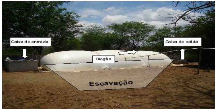
FIGURA 7 – Esquema do biodigestor de lona de PVC.
