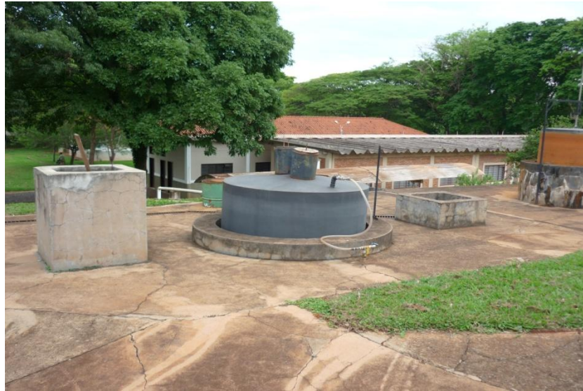
FIGURA 2- Biodigestor do tipo indiano (Departamento de Engenharia Rural – UNESP/Jaboticabal).
