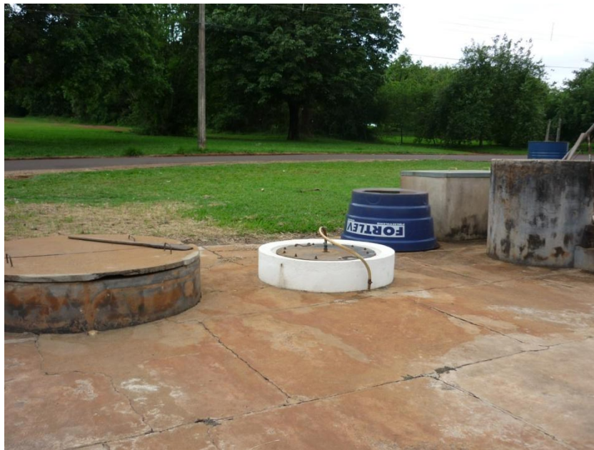
FIGURA 4- Biodigestor modelo chinês (Departamento de Engenharia Rural – UNESP/Jaboticabal).
