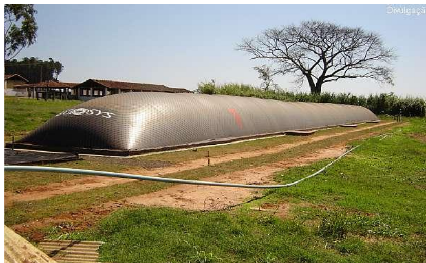
FIGURA 6 – Biodigestor com gasômetro de lona de PVC (Departamento de Engenharia Rural – UNESP/Jaboticabal).
