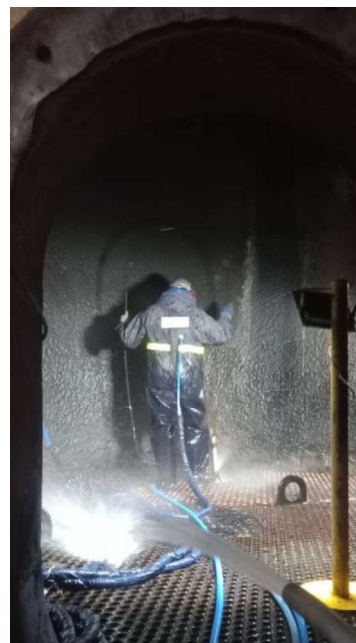
Colaborador Hidrojateando Evaporador de Caldo Autor
