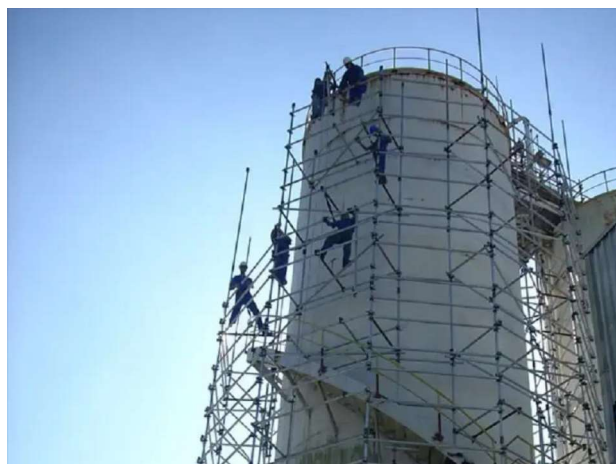
Montagem de Andaime Multidirecional Imagem da internet, acesso em 30/08/2025
