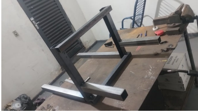
Figura 1: Parte da estrutura
