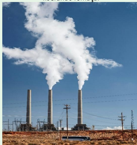
Figura 6 - Chaminé de uma fábrica de concreto liberando fumaça.
