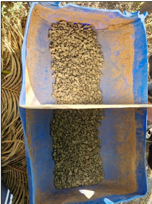
Figura 31 - Pedra brita no fundo
