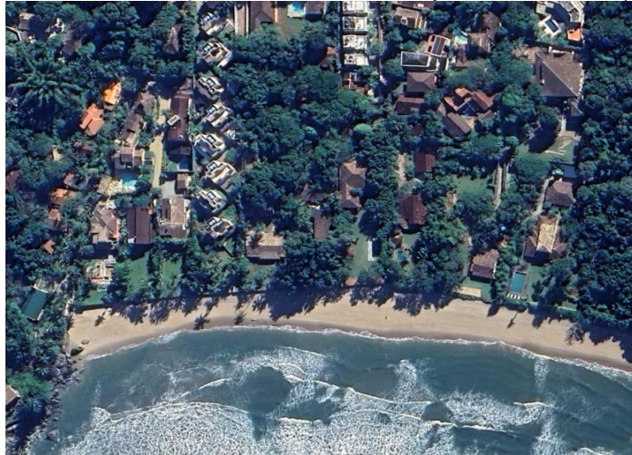
Figura 04 – Vista superior da Barra do Sahy, São Sebastião (SP).
