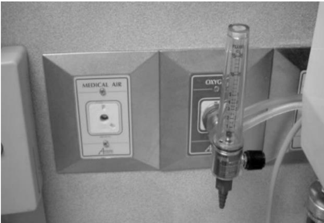
Figura 1: Exemplo de Poka-yoke na administração de nitrogênio e oxigênio. Fonte: baseado em Carlson e May. Mistake Proofing for Lean Healthcare. Lean Tools for Healthcare Series. Rona Consulting Group & Productivity Press, 2016.
