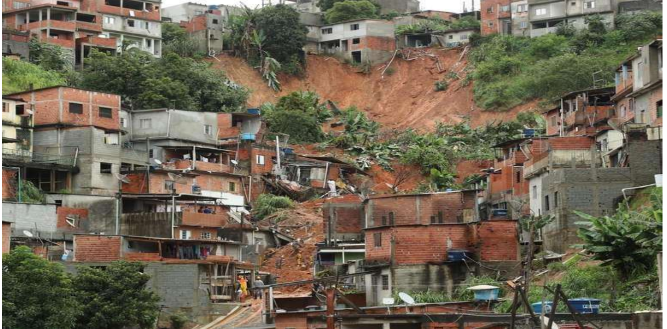
Figura 11 – Vulnerabilidade: Características da ocupação.
