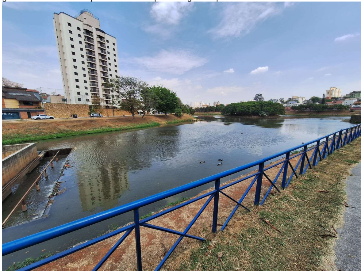
Figura 58 – Bacia de retenção em Sorocaba para filtragem de poluentes/sedimentos e controle de cheias.
