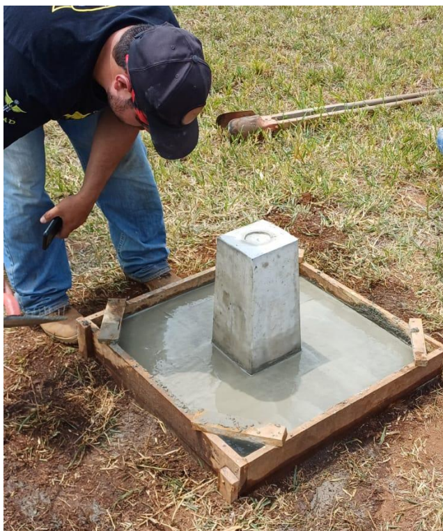
FIGURA 16 - EXECUÇÃO DO MARCO TOPOGRÁFICO
