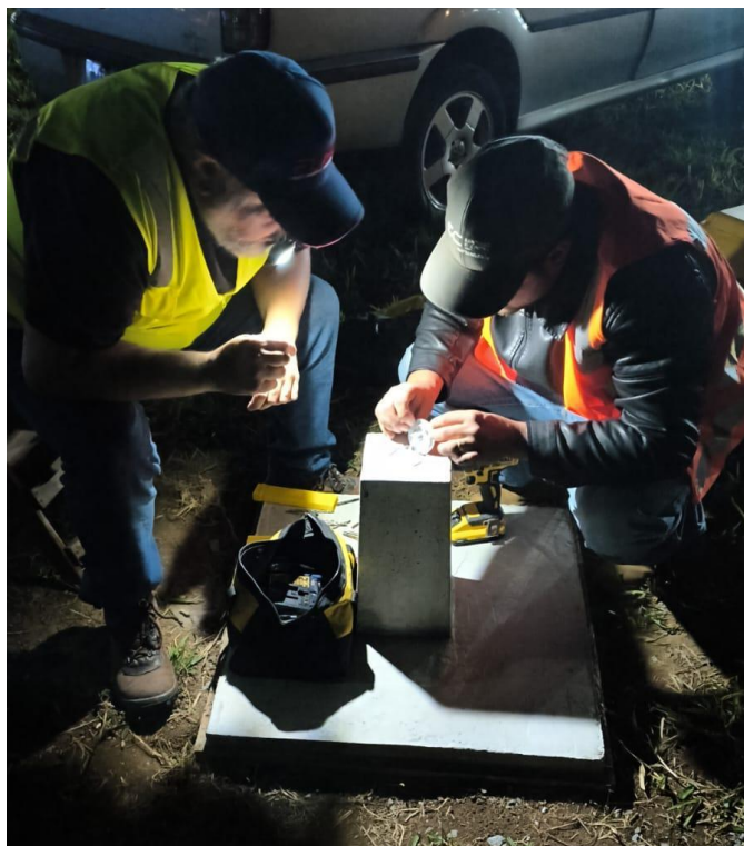
FIGURA 18 - IMPLANTAÇÃO DO EIXO DA PLACA PARA PORCIONAMENTO DO MARCO
