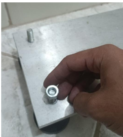
Figura 26. Processo de Montagem do PN MICRO II na Estrutura
